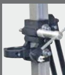
Монтаж переходной муфты
