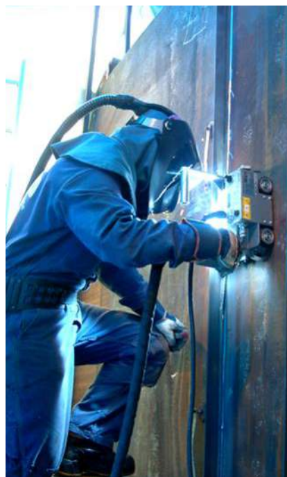
Вертикальная сварка встык вверх с помощью направляющей
