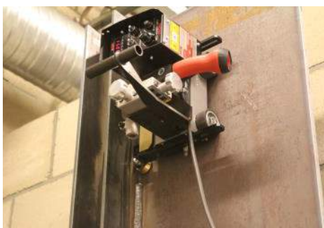
Вертикальная сварка желоба
