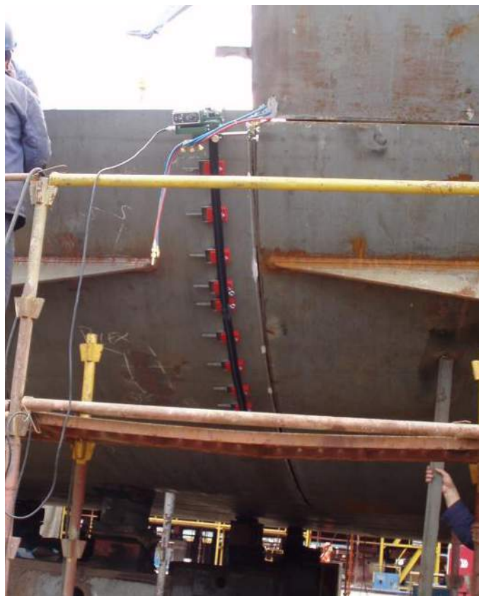
Подготовка к сварке с 2D рельсами
